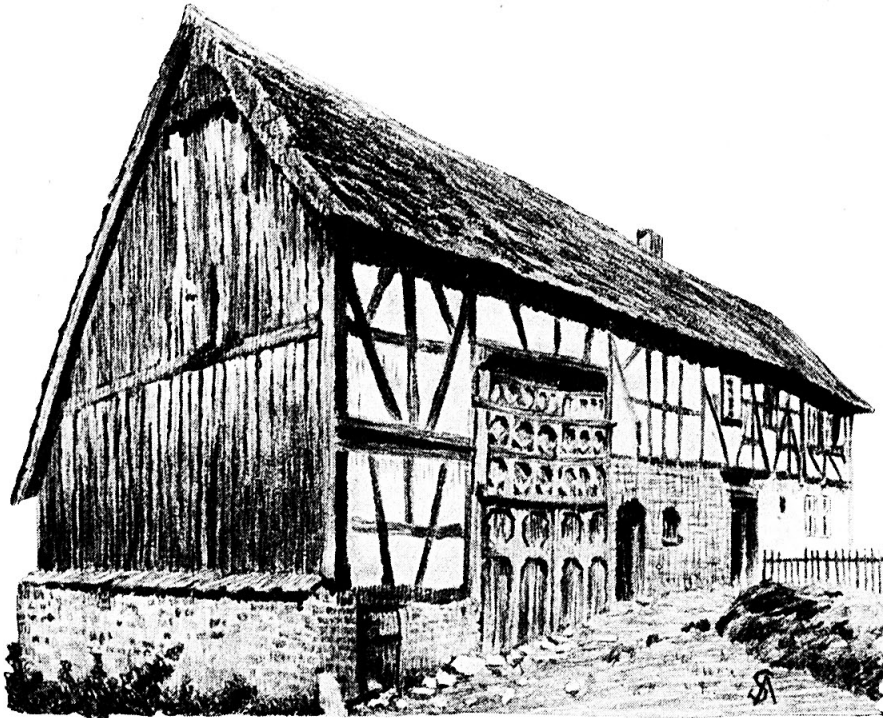
52. Westerwaldhaus mit Niederlaß 'Verlängerung des Hausdachs auf der Wetterseite'.
