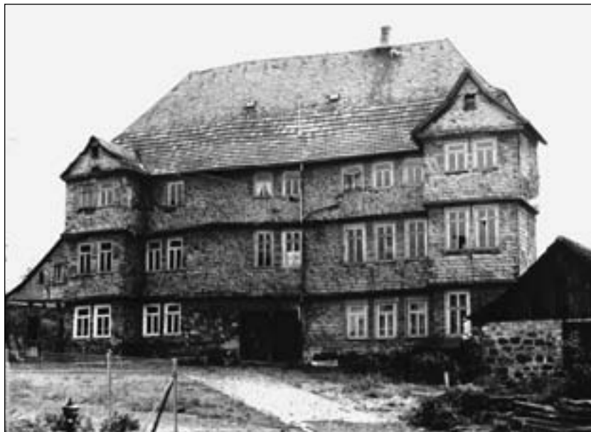
Die Burg in Grünberg, Fotografie, ca. 1960 (StadtA Grünberg, ohne Signatur). Von der mittelalterlichen Burg waren bereits zu Beginn der Neuzeit fast keine Spuren mehr vorhanden. Anfang des 19. Jhs. erinnerte noch ein kleiner Tümpel an den ehemaligen Burggraben (vgl. Urkatasterkarte 1:2.500 in dieser Atlasmappe). Bei dem hier gezeigten 1969 abgerissenen Gebäude (erbaut 1553) handelt es sich um einen für die Jahrzehnte um die Mitte des 16. Jhs. typischen Renaissancebau, wie er als Amtshaus, Jagdschloss, Witwensitz u.ä. damals an vielen Orten der Landgrafschaft verwendet wurde. Die stadtzugewandte Fassade des dreistöckigen verschieferten Fachwerkbaus folgt einer strengen Symmetrie. Rechts und links springen zwei Eckerker mit je zwei Fensterachsen vor. In der Mitte über dem Eingang befinden sind zwei Fensterachsen, rechts und links davon jeweils drei, wobei im linken Gebäudeteil vier Fenster nachträglich vermauert worden sind, wie an der Verschieferung deutlich zu erkennen ist. Die Doppeltür dürfte erst nach 1801 eingebaut worden sein (HStAD P 11 Nr. 216/1-2, Plan des Burggeländes und Grundriss der Burg). Die Neuvermessung des Geländes im Zuge der Errichtung der Terrassenhäuser Anfang der 1970er Jahre hat als letzte Spur der Burganlage auch die Parzellengrenzen verwischt (vgl. Grundrissplan auf dem Sonderblatt in dieser Atlasmappe).
