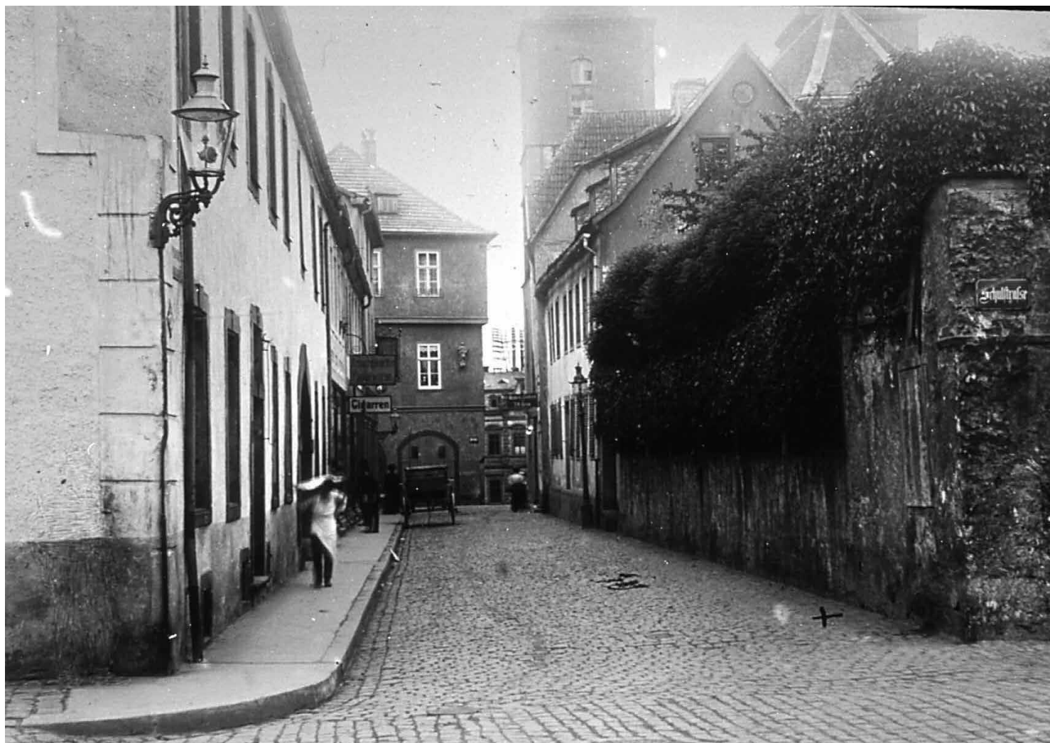
Abb. 10: Blick in die Borgiasstraße von Nordosten in Richtung altem Rathaus, 1911 (Fotografie, StA Fulda, Inv. Nr. BA-35.107). Die Borgiasstraße, anfangs Ignatiusstraße genannt, entstand um 1777 nach der Aufhebung des Jesuitenkollegs. Der Borgiasbau auf der linken Seite diente bis 1886 als Schullokal. Die ehemals in der Ecknische links über der Laterne befindliche Statue des Hl. Ignatius war bereits entfernt worden (STURM, Bau- und Kunstdenkmale, S. 530 f.). Der Blick geht auf die Ostfassade des alten Rathauses. Zwischen ihm und dem südlichen Stadtkirchturm ist ein Teil der Front des 1878–80 erbauten Gebäudes der Reichspost zu erkennen.
